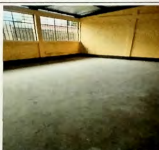
Foto 6: MODULO B aula lateral derecha, se instalo piso ceramico sobre base de concreto.
