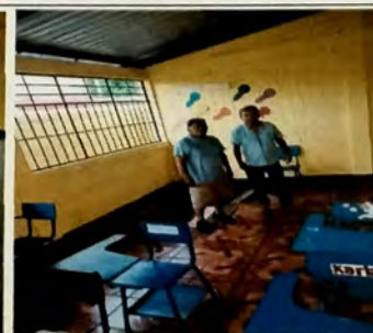
Foto 6: MODULO B aula lateral derecha, se instalo piso ceramico sobre base de concreto.
